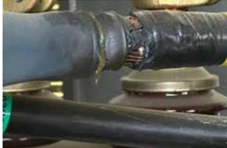
▲ Durch thermische Einwirkung freiliegende Schirmdrähte der Anlage NE-La Aichen
