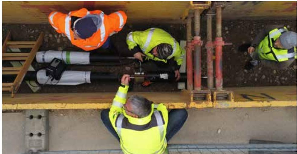
▲ Auf der Fernwärmebaustelle in Emmerting: Günter Kapsreiter (Bauleiter der EGIS Verwaltungs GmbH) überwacht die erste Pressung der Fernwärmeleitung.
