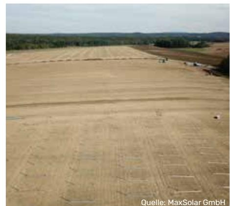
Auf der 125 Hektar großen Freifläche rollten im September 2022 die Baufahrzeuge an. Die ersten Ramppfeiler für die Modulreihen standen zu diesem Zeitpunkt bereits.
