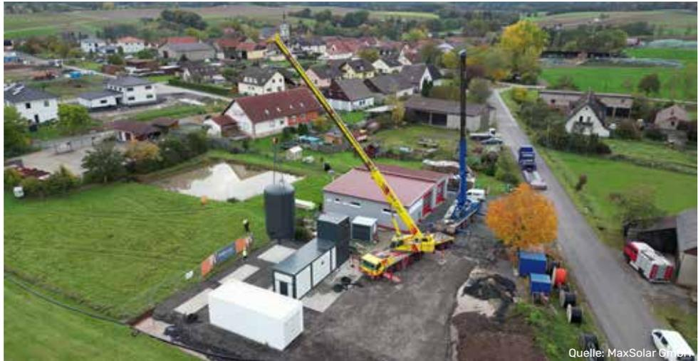
Am 09. Oktober 2023 begann der Bau des Heizhauses. Auf dem Bild wird gerade der 70.000 Liter Pufferspeicher angeliefert und installiert.
